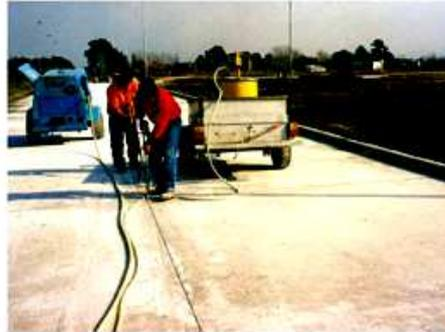
Para controlar y reducir los efectos perjudiciales del agrietado, o para transferir las cargas entre losas adyacentes, se acude al uso de *hierros redondos de distribución o barras de anclaje y pasadores*.
